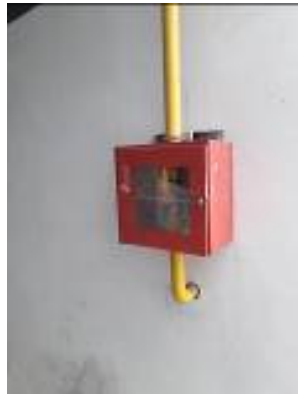
Photo n°1 : Vanne de barrage extérieure « chaufferie process » Photo n°2 : Vanne de barrage intérieure « réseau aérotherme »
