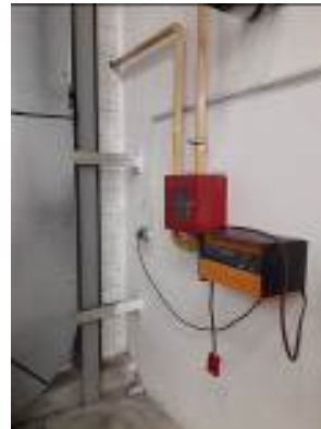
Photo n°1 : Vanne de barrage extérieure « chaufferie process » Photo n°2 : Vanne de barrage intérieure « réseau aérotherme »
